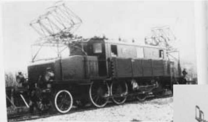
DS-Ellok FS E470.001 (1925) Schnellzuglok bis 100 km/h 10 kV, 45 Hz, 2 MW
