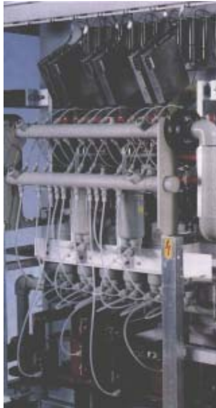
Statischer 100 MW-GTO-Frequenzumformer 50 Hz zu 16 2/3 Hz für die Bahnstromversorgung der DB AG in Bremen (ADtranz 1996)
