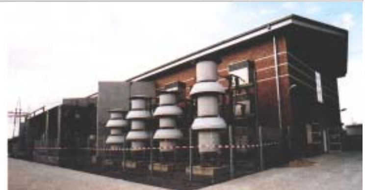
Statischer 100 MW-GTO-Frequenzumformer 50 Hz zu 16 2/3 Hz für die Bahnstromversorgung der DB AG in Bremen (ADtranz 1996)
