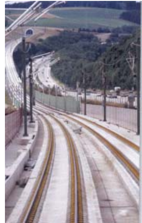
Neubaustrecke Frankfurt -Köln (2003)
